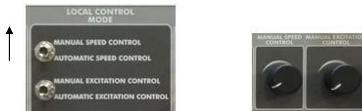
**Figura 44: Control local / control manual de velocidad con potenciómetro**
