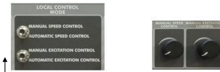
**Figura 46: control local / control manual de la excitación con potenciómetro**
